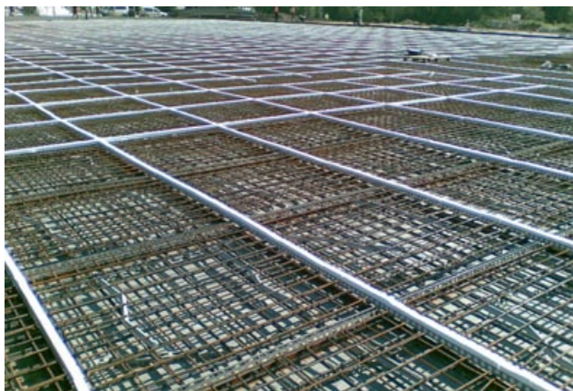
Fot. 1. Widok platformy żelbetowej po zakończeniu układania zbrojenia
